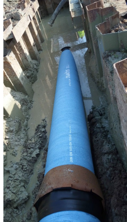
Funktionsprüfung des Bohrkopfes vor dem Rohreinzug – Einzug des Rohres in das Bohrloch
