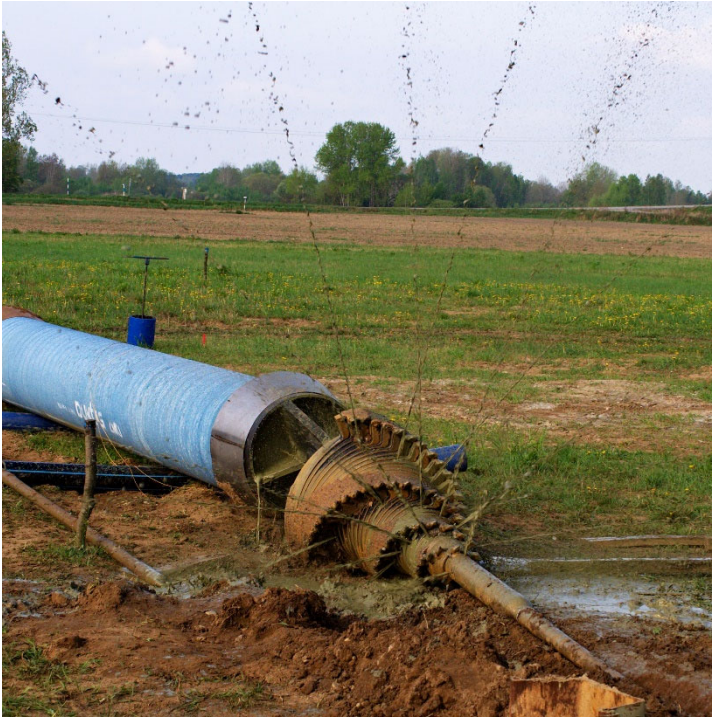
Funktionsprüfung des Bohrkopfes vor dem Rohreinzug – Einzug des Rohres in das Bohrloch
