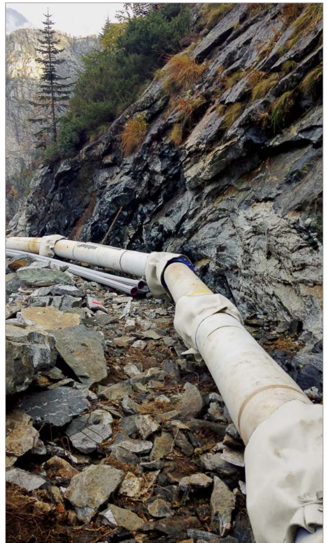
Bild 5: Abwinkelbare Steckmuffen-Verbindung HYDROTIGHT
