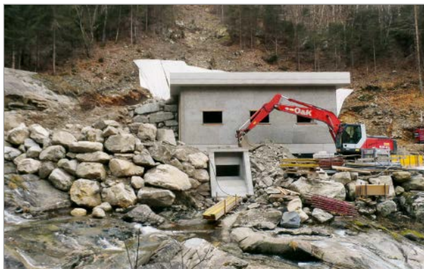
Bild 13: Kraftwerksgebäude mit unterirdischem Kanal für die Wasserrückgabe in den Gebirgsbach Tomé
