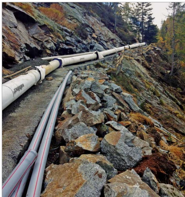
Bild 7: Druckleitung ECOPUR oberirdisch auf Fels eingebaut
