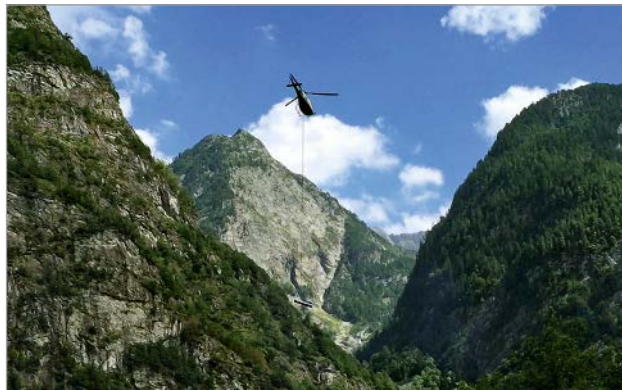
Bild 6: Transport und Einbau der ECOPUR-Rohre mit Helikopter
