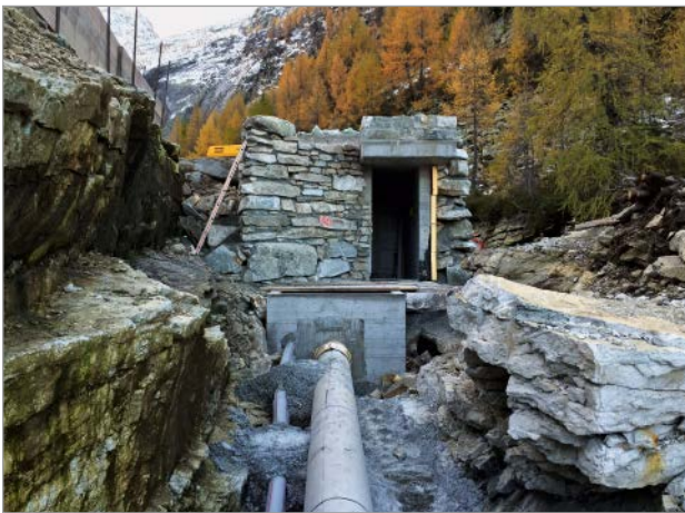
Bild 3: Einlaufbauwerk mit Tessiner Naturstein verkleidet
