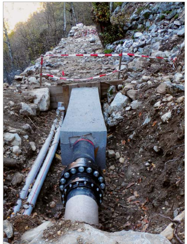
Bild 11: Übergang duktiles Gusseisen – Stahl, Sonderformstück, Flanschmuffenstück (E), mit Flanschen PN 100 bar
